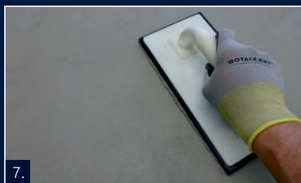
7. Nanesenou vrstvu po zavadnutí zahladit /vytvarovat vhodným náčiním, např. gumovým hladítkem, suchou houbou.
