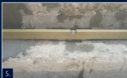
5. Vrstvy lze provádět vodorovně nebo ve spádu.
