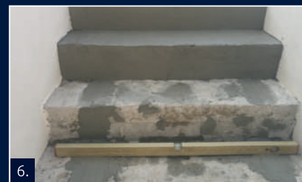
6. Hrany a kouty lze optimálně tvarovat.
