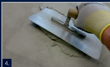
4. Na čerstvou kontaktní vrstvu nanášet materiál a vyrovnat.
