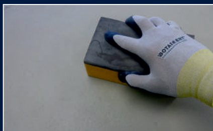
7. Nanesenou vrstvu po zavadnutí zahladit /vytvarovat vhodným náčiním, např. gumovým hladítkem, suchou houbou.
