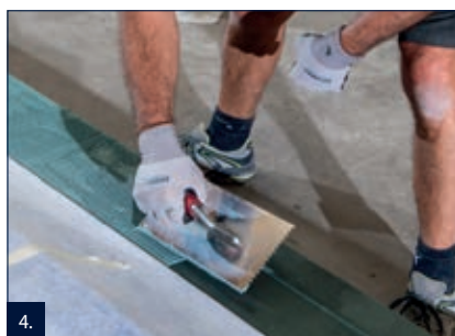
4. Na proschlou vrstvu celoplošně nanést RD 2 pomocí zubové stěrky.
