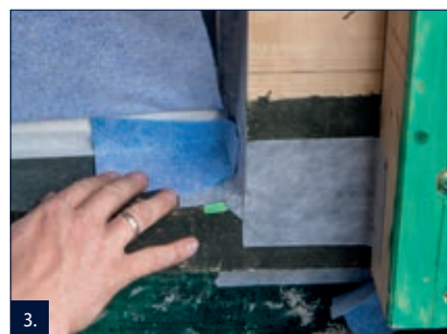
3. Pásku PB i hotové systémové prvky v koutech a na nárožích předem seříznout na potřebný rozměr.
