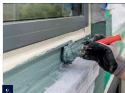
9. Následně překrýt alespoň okraje pásky PB hmotou RD 2, aby se zabránilo zatečení pod pásku.
