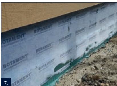
7. Izolační pásku uložit bez zvrásnění.
