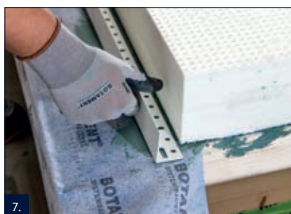
7. Soklový ukončovací profil zapracovat do čerstvé hmoty RD 2.
