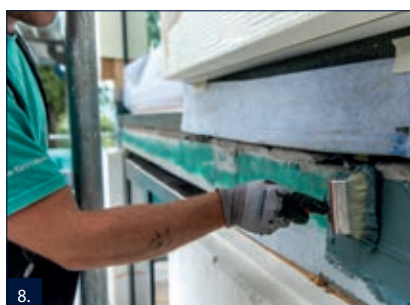
8. Po usazení stěnového elementu na stavbě propojit pásku PB se základovou deskou nebo izolací soklu. Za tímto účelem celoplošně rozprostřít na proschlou uzavírající vrstvu hmotu RD 2.
