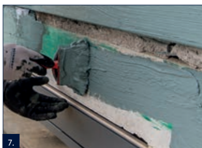
7. Na podklady, kde se bude ukládat páska PB, celoplošně nanést vrstvu hmoty RD 2 pomocí štětce nebo zubové stěrky.
