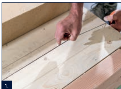
1. Vyměření a označení výšky hydroizolace.
