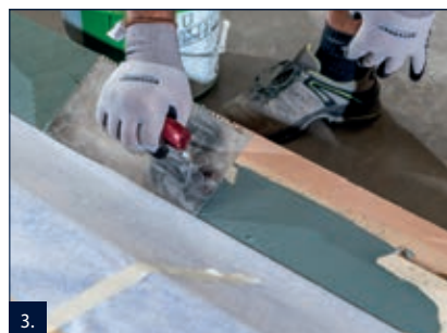
3. Překlopit izolační pásku PB a provést uzavírající vrstvu hmoty RD 2.
