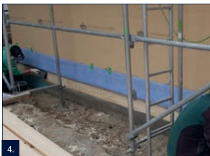
4. Izolační pásku PB přehnout nahoru a provizorně přichytit pomocí lepicí pásky.
