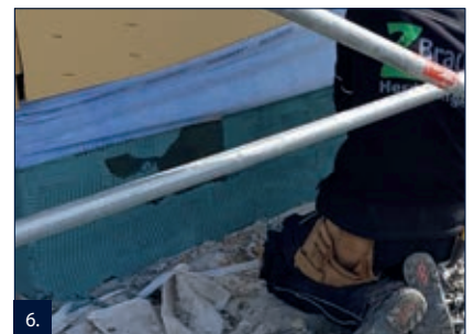
6. Hmotu RD 2 celoplošně nanést na proschlou uzavírající vrstvu pomocí zubové stěrky.
