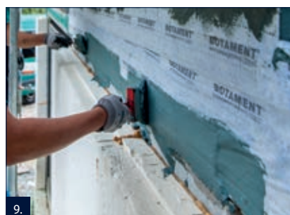
9. Uložit izolační pásku PB do čerstvé vrstvy RD 2 bez zvrásnění a svědomitě překrýt okrajové části hmotou RD 2.
