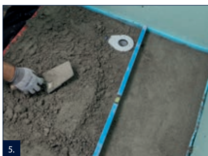
5. Na olejový papír nebo PE fólii vytvořit vodorovnou vrstvu rychlovačným potěrem M 54FM v požadované výšce.
