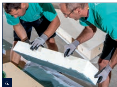
6. Připravenou tepelně-izolační desku přilepit do hmoty RD 2 kombinovanou metodou (Buttering-Floating) na pásku PB.
