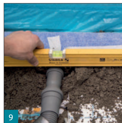
9 Dodatečná kontrola usazení žlabu Water LD.
