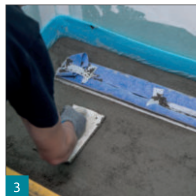
3 Zahlazení povrchu potěru.
