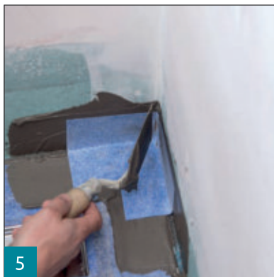
5 Uložení systémových prvků SB 78 do tmelu M 21, příp. prémiového rychleschnoucího M 21 HP Speed.
