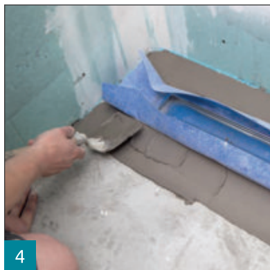
4 Uložení manžety žlabu do tmelu M 21, příp. prémiového rychleschnoucího M 21 HP Speed.
