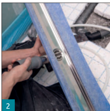
2 Napojení volitelné flexibilní trubky.
