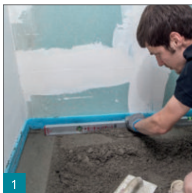
1 Vytvoření omítníků pomocí rychlovlazného potěru M 54 FM .
