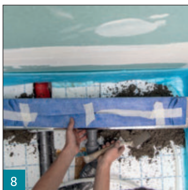
8 Podsypaní žlabu Water LD potěrem M 54 FM.
