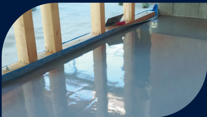
Hydroizolace základových desek na terénu – novostavby
