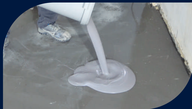
Hydroizolace základových desek na terénu – sanace
