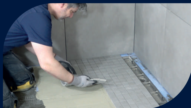
Spojená hydroizolace pod keramickými dlaždicemi
