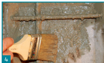
4 Povrch betonu důkladně zvlhčit a vytvořit kontaktní nátěr Renovation HB1.
