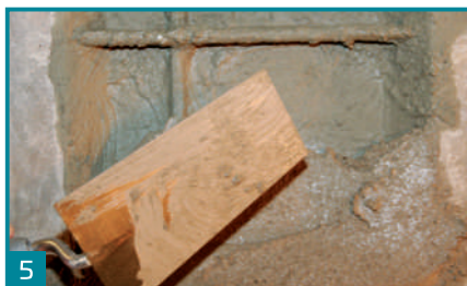
5 Opravnou maltu M03 nanášet do čerstvého kontaktního můstku.
