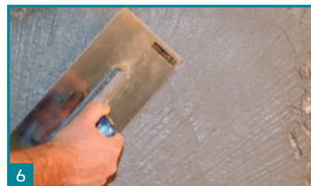
6 Nanášení jemné stěrkové hmoty Botament M57.
