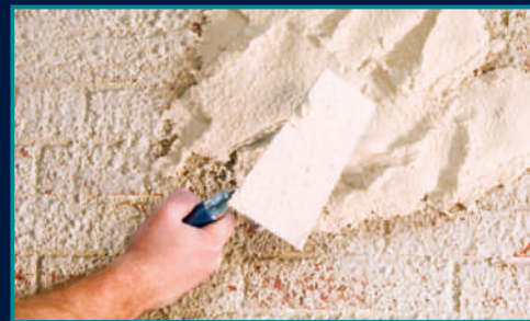
Nanášení omítky Renovation FSP
