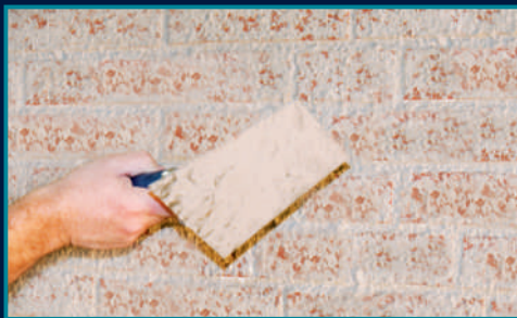
Provedení podhozu Renovation VSM
