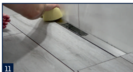
11 Očištění krycí části a spár.
