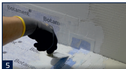
5 Provedení hydroizolační vrstvy hmotou Multiproof.
