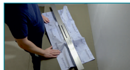
Těsnicí manžeta je spojena se žlabem.
