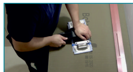
Nasazení sifonu na žlab.
