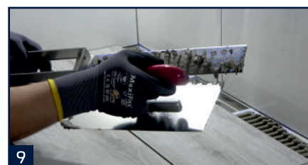
9 Nanesení lepidla na rub krycí části.
