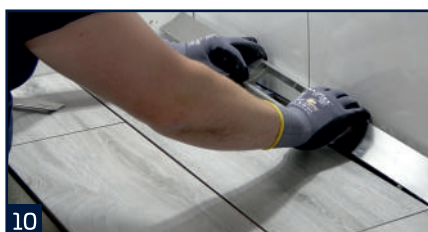
10 Osazení krycí části žlabu.
