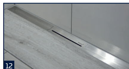
12 Žlab po zaspárování.
