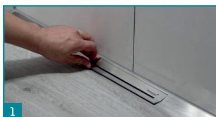
1 Postup čištění sifonu » odklopení víčka žlabu.
