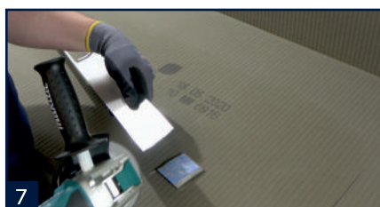
7 Zkrácení krycí části pomocí úhlové brusky.
