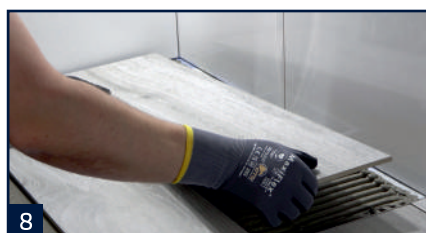
8 Uložení dlaždic do lepicího tmele Botament.
