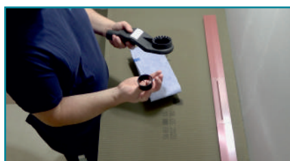
Sifon BA-LD V DN 40 horizontální – zápachová uzávěra.
