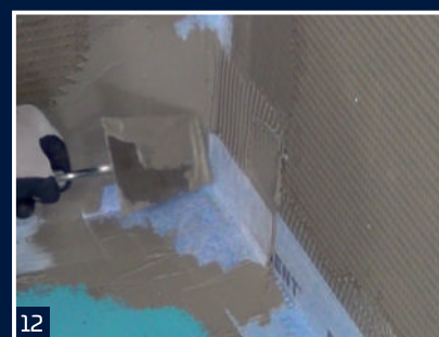
12 Zatření okrajových částí koutového prvku
