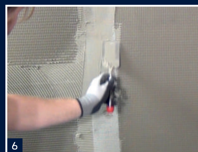
6 Zatažení pásky lepidlem BOTAMENT® M21
