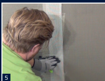
5 Fixace armovací pásky BOTAMENT® GS12
