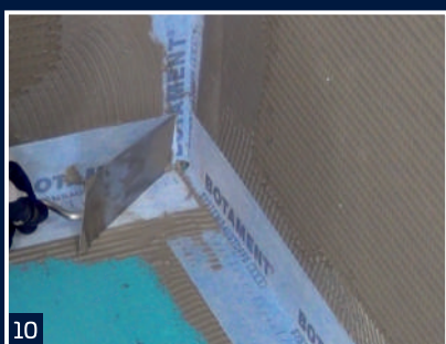
10 Uložení izolační pásky BOTAMENT® SB78 přes napojení desek BP a sprchový desek
