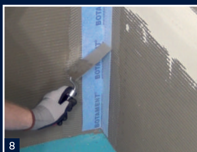
8 Uložení izolační pásky BOTAMENT® SB78 do čerstvé vrstvy MD1 Speed
