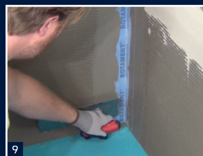
9 Zatření okrajových částí pásky
