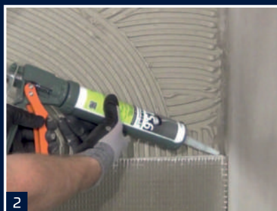
2 Lepení spojů konstrukčních desek BP tmelem BOTAMENT® MS6 (Upozornění: netvořit spáry do kříže)
