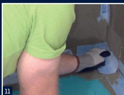
11 Uložení hotových prvků izolační pásky BOTAMENT® SB78 kout
