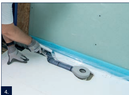
4. Na úroveň instalace uložit izolaci kročejového hluku.
