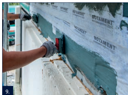
9. Uložit izolační pásku PB do čerstvé vrstvy RD 2 bez zvrásnění a svědomitě překrýt okrajové části hmotou RD 2.
