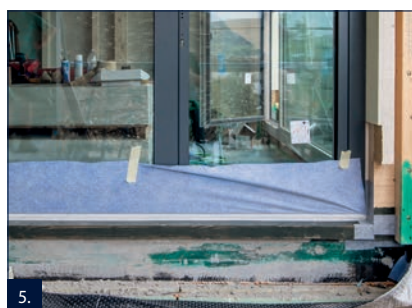
5. Pro zjednodušení pracovního kroku provizorně přilepit pás PB ke dveřím samolepicí páskou.
