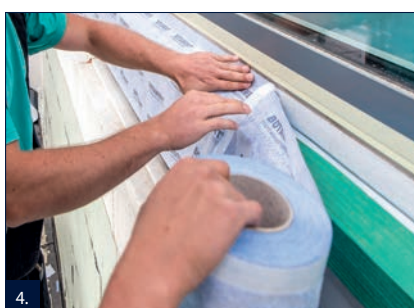
4. Pásku PB fixovat pomocí lepicího proužku na rám.
