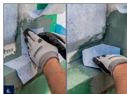
6. Připravené systémové prvky zcela uložit do vrstvy RD 2 a srovnat.
