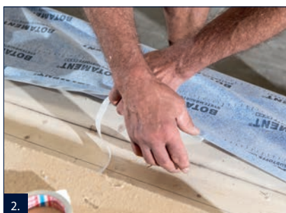
2. Fixace izolační pásky PB pomocí lepicího proužku na stěnový díl.
