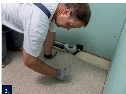
2. Na dřevěný podklad pod potrubí celoplošně uložit tlumící rohož TE Plus.
