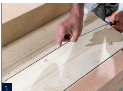
1. Vyměření a označení výšky hydroizolace.
