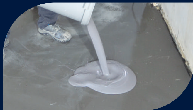
Hydroizolace základových desek na terénu – sanace
