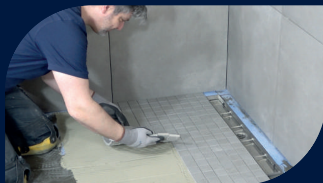
Spojená hydroizolace pod keramickými dlaždicemi
