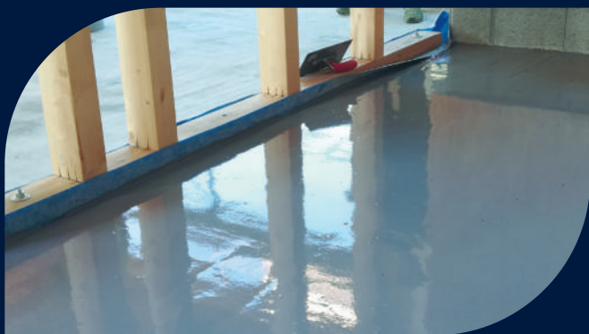
Hydroizolace základových desek na terénu – novostavby
