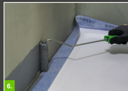
6. Izolační pásku uložit do prováděné první vrstvy hydroizolační hmoty.
