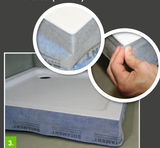
3. Případně (v závislosti na zaoblení vany): vytvořit „kapsu“ pro získání koutů bez pnutí.
