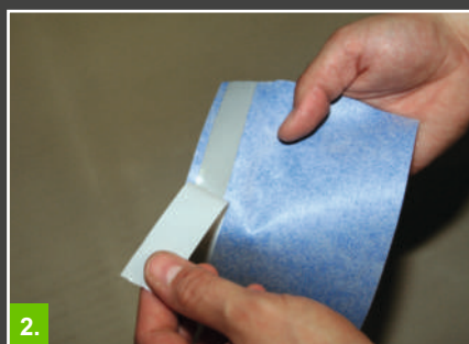
2. Sejmout ochrannou fólii z butylové vrstvy a následně přilepit pásku bez bublin, či vrásek na okraj vany (nepřerušovat na rozích).
