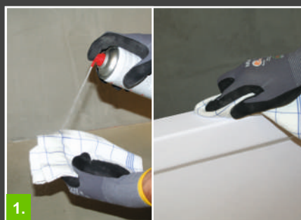
1. Očistit okraj vany prostředkem neobsahujícím rozpouštědla.
