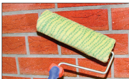
Nanášení BOTAMENT® MS 80 W válčkem nebo štětcem
