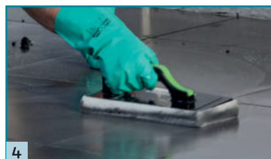
5 Následuje formování spár a omytí plochy pomocí houby na spárování.
