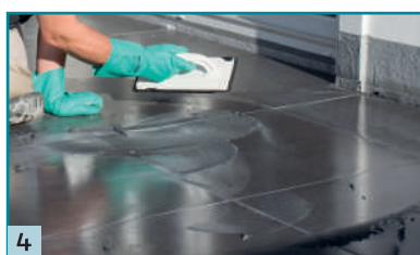
4 Spárovací hmotu Multifuge Diamond Max lze snadno aplikovat pomocí gumové stěrky na epoxid. Teplota vzduchu a podkladu při zpracování v rozmezí +10 °C až +25 °C.
