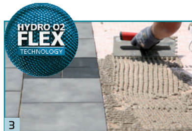
3 Lepicí tmel BTK200 se nanáší odpovídající zubovou stěrkou dle velikosti formátu dlaždic. Metoda oboustranného nanášení, pro získání lože bez dutin, není v tomto případě požadována.
