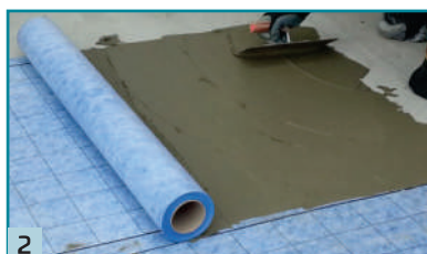
2 Po aplikaci a proschnutí penetrace D11 se lepí fólie AE do rychleschnoucího tmelu M21 HP Speed, naneseného na podklad 4 mm zubovou stěrkou.
