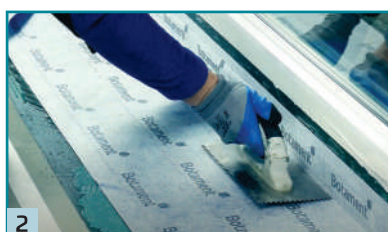
2 Uložení izolačního pásu PB do reaktivní hydroizolační stěrky RD2 The Green 1.
