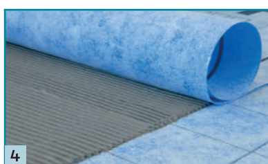
4 Uložení izolační a dělicí fólie AE s přesazením 5 cm do lepicího tmelu M 21 nebo M21 HP Speed.
