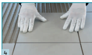
4 Kladení dlaždic do lepicího lůžka tmelu M29 HP nebo M21 HP Speed.
