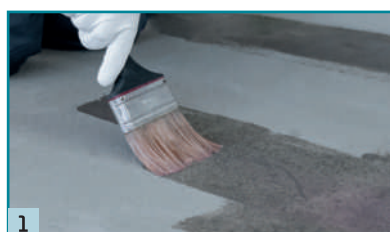
1 Penetrace podkladu nátěrem D11 nebo D1 Speed.
