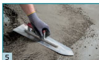
5 Uložení rychleschnoucího potěru M54 FM nebo M56 Speed FM.
