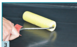
3 Nalepení bitumenového pásu KSK na vrstvu tepelné izolace.
