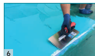
6 Nanášení izolační stěrky RD2 The Green 1 ve dvou vrstvách.
