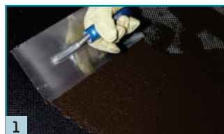
1 Nanášení živичné stěrkové hmoty BM92 ve dvou vrstvách.
